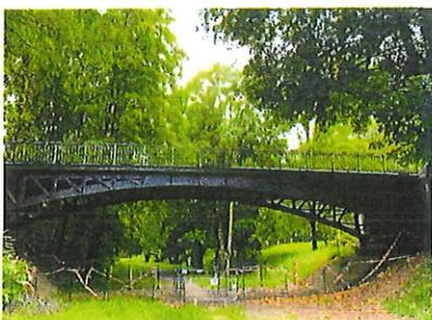
Le pont sur l'avenue du Marechal Joffre, donnant accès au quartier des Villas Alexandre et des prés Gallier, nécessite des travaux de réfection au niveau du tablier. Nous avons pris des mesures de sécurité en installant un portique à l'entrée pour interdire le passage des poids lourds et du grillage sous le pont pour empêcher la circulation des piétons.
